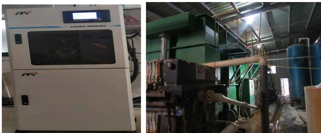
图 5 企业废水在线监测设备和排放检测情况
